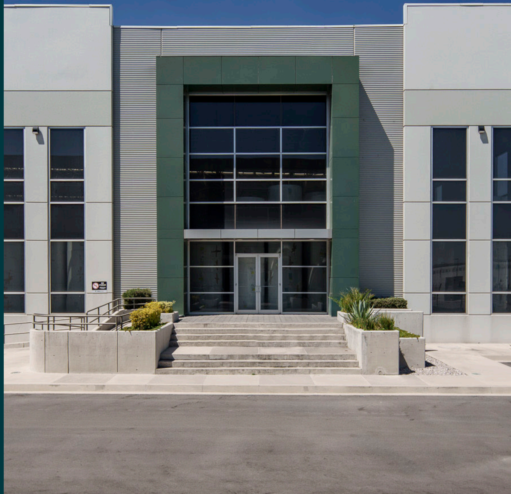
Fotografía: Prologis Park Grande, Ciudad de México.
