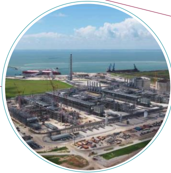
Corpus Christi LNG Terminal ~25+ mtpa Total Production Capacity
